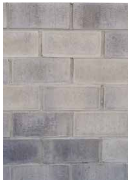
Mauer mit vermörtelten Fugen
